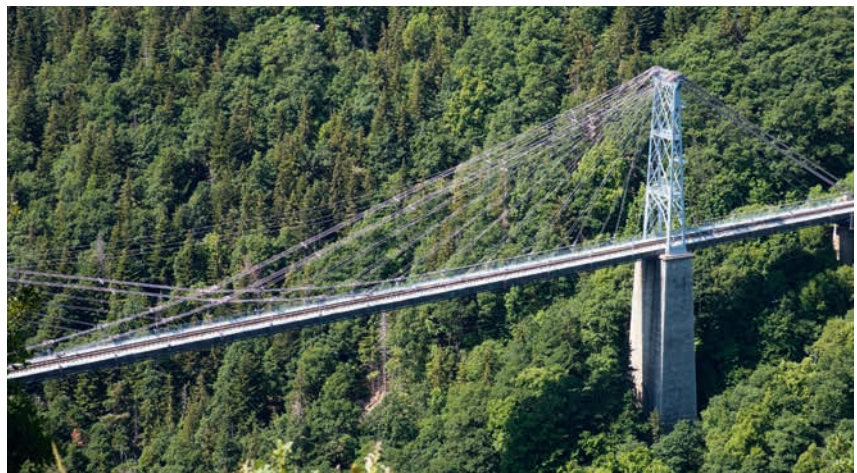
Le petit train jaune de la ligne de Cerdagne emprunte le pont de Cassagne depuis le début du XX e siècle. Seulement 62 km de trajet, mais qui ont nécessité 650 ouvrages d'art pour franchir ces vallées.
